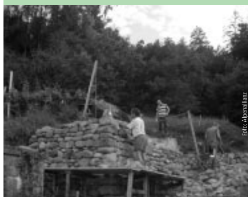
Röthis sanierte im Rahmen von DYNALP Trockenmauern mit arbeitslosen Jugendlichen.
