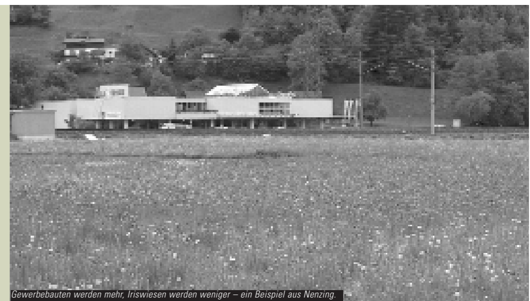
Gewerbebauten werden mehr, Iriswiesen werden weniger – ein Beispiel aus Nenzing.
