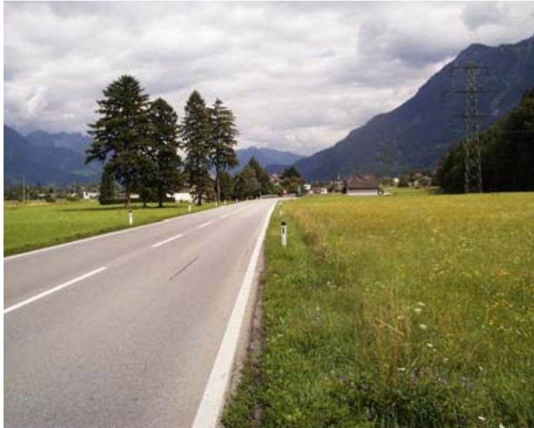
Abbildung 1: Standort der Saugkerzenanlage
