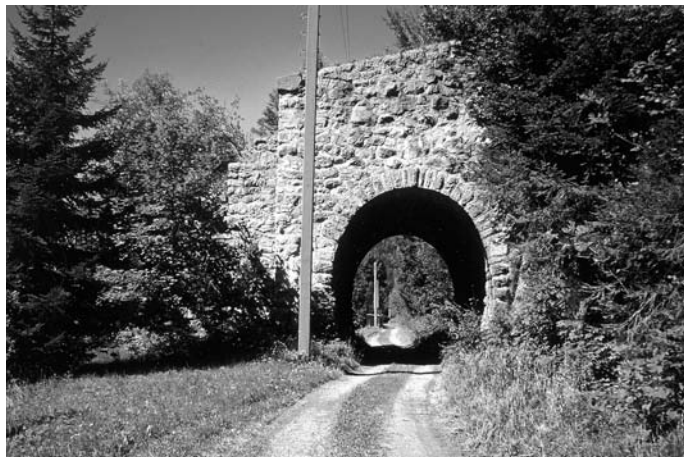
Abb. 3: Die seit dem Bau des Wildentobel-tunnels zwischen Wald und Klösterle nicht mehr benötigte Bahn-trasse dient heute als Wanderweg (Foto: Verf.).
