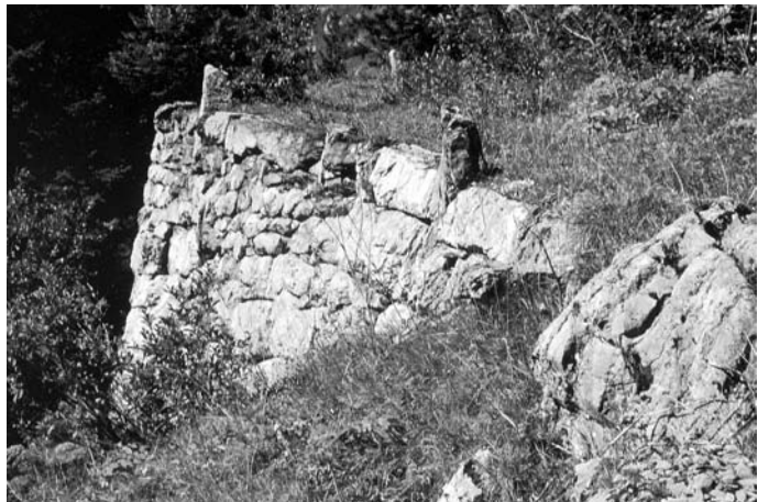
Abb. 2: Kehren der alten Flexenstraße oberhalb von Stuben (Foto: Verf.).
