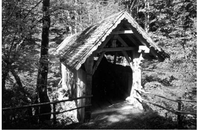
Abb. 1: Die 1789 erbaute Lasangabrücke bei Raggal ist eine der ältesten gedeckten Holzbrücken in Vorarlberg (Foto: Verf.).
