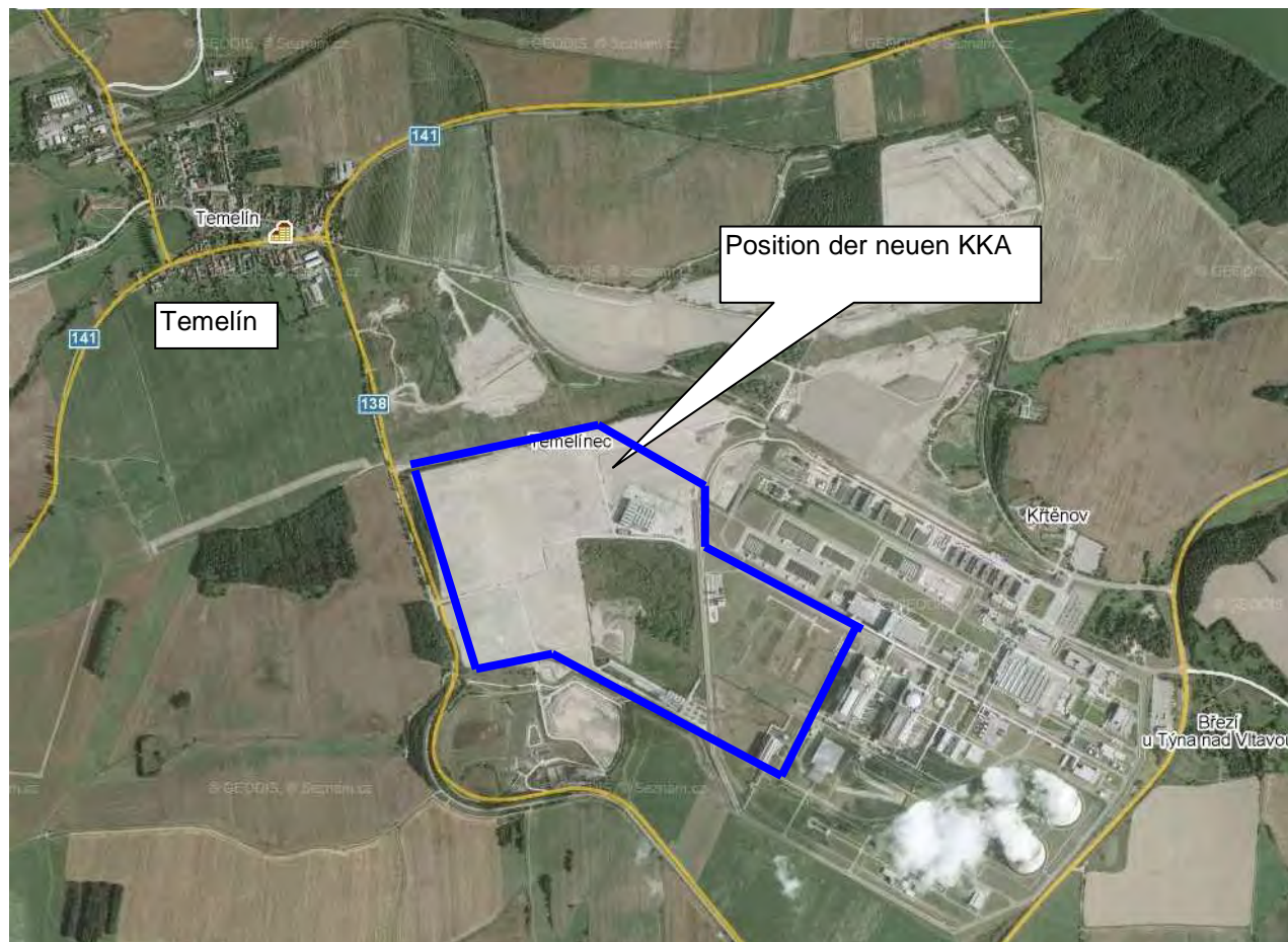
Bild 4.4.2 Situation am Standort des KKW Temelín
