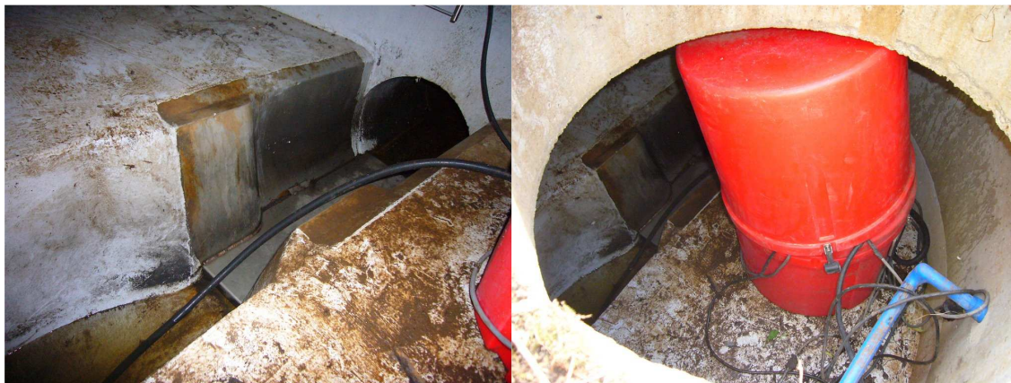
Abbildung 2: Venturigerinne und automatisches Probenahmegeräte im Messschacht
