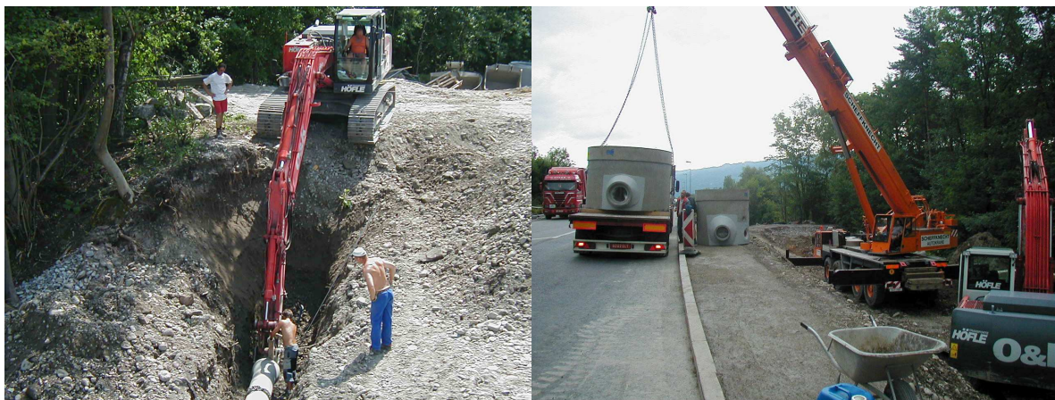
Abbildung 11: Zulauf und Vorreinigungsanlagen im Bauzustand Juli 2003
