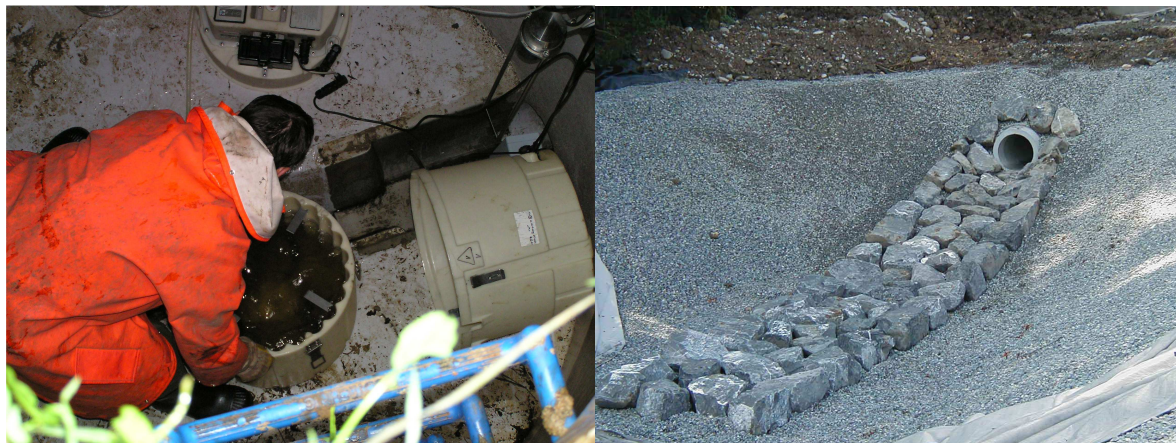
Abbildung 4: Mess- und Probenahmestelle im Ablauf sowie Filterbeckenzulauf in Bau
